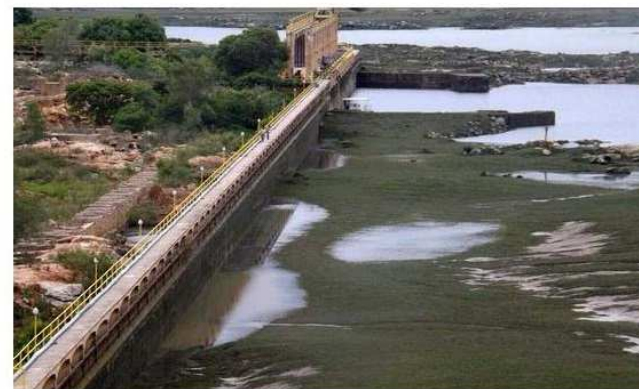
Com recuo das águas na altura da hidrelétrica de Xingó, na região Nordeste, algas acumuladas formaram um tapete verde próximo à estrutura da barragem
